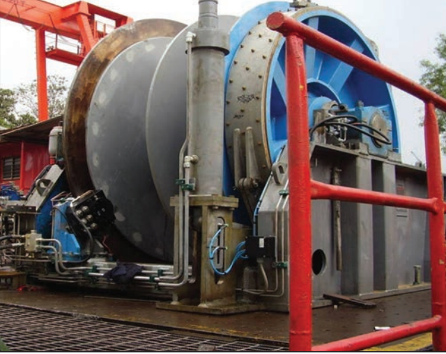
Tersane Vinci Frenleme Uygulaması
